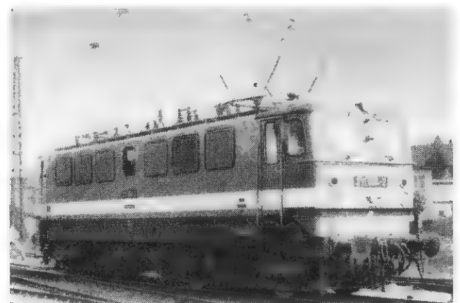
Bild 5 Die 211 054-2 der Lieferserie 1971/72 mit erstmalig abweichender Farbgebung; Lokkasten signalrot, Hauptrahmen schwarz, Drehgestell grau
