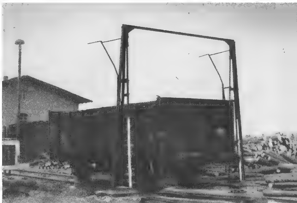
Ein Wagen, in diesem Fall allerdings unbeladen, wird zur Kontrolle durch die Ladelehre geschoben Foto: Reinfried Knöbel, Dresden
