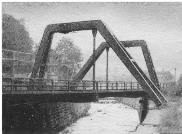
Bild 5 Ausführung der Portalrahmen
